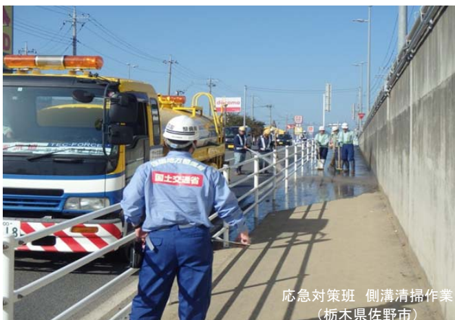
排水ポンプ車による緊急排水状況 (長野県長野市)
