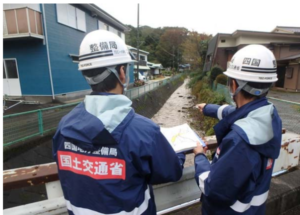
R1.10.25 道路班 被災状況調査 （神奈川県足柄上郡松田町）
